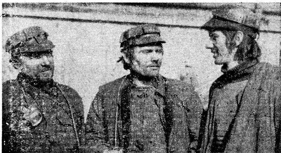
Brigada condusă de Nicolae Rușanu, de la I.M. Lupeni participă la montarea în subteran a noilor complexe mecanizate de susținere.
