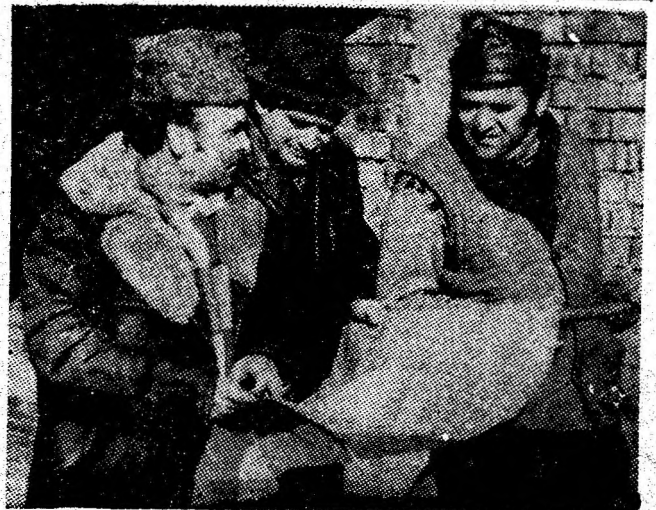
Sing. Constantin Cățătoru, șeful șantierului 4 Lupeni — lot Uricani, într-o discuție cu dirigintele șantierului, Ion Avram, și fierar-betonistul Tudor Păcurar. Foto: Ioan BALOI
