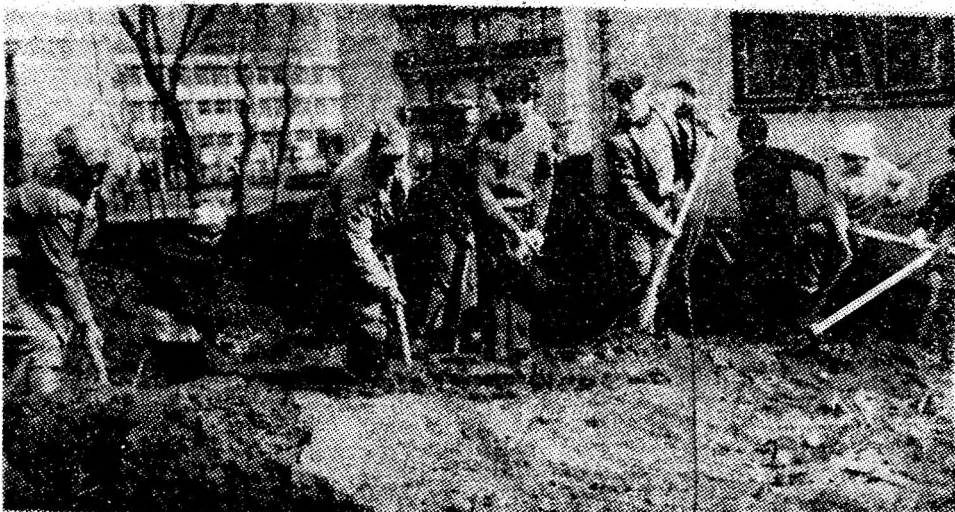
În fața blocului 10 de pe Aleea Crizantemelor din Vulcan, locatarii curăță pămîntul rămas de la săparea unui șant de termoficare.
