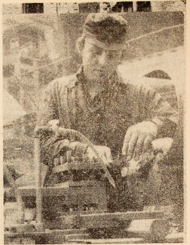
Instantaneu în noul atelier de prelucrare a elementelor de hidraulică (hala 106) al I.U.M.P., unde obiectivul aparatului l-a surprins pe harnicul strungar Gheorghe Rad în timpul prelucrării și verificării unui ventil pentru combina CA-2.
