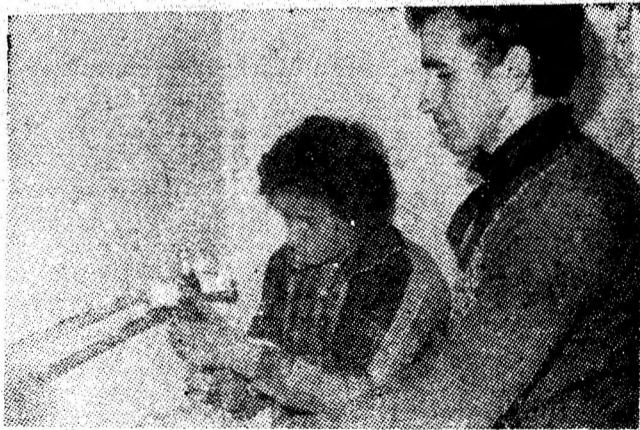
Instalatorii sanitari Victor Olteanu și Mircea Contiș, doi tineri muncitori ai Grupului de șantier Alba Iulia, ce lucrează în zona noului centru civic din Vulcan.
