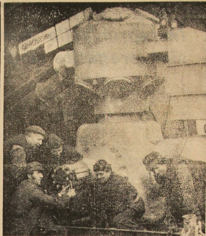
Echipa de lăcătuși condusă de Cornel Ciulea, lucrează la montarea unui nou compresor în vederea măririi capacității de debitare a aerului comprimat la stația de compresoare nr. 1 de la I.M. Petroșeni.
