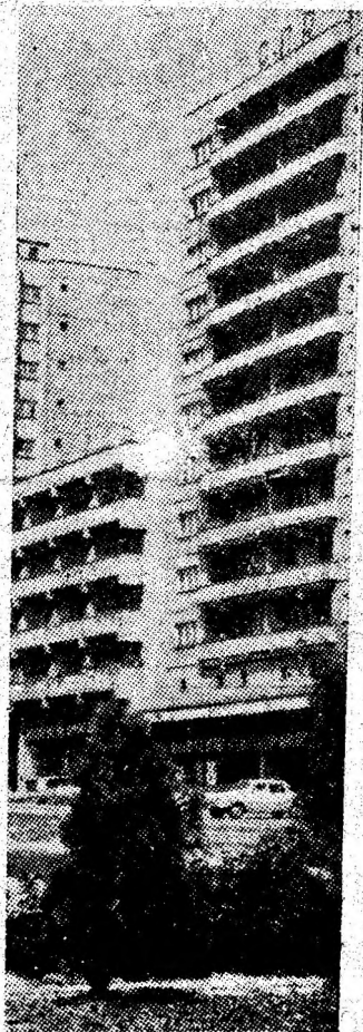
Verticale arhitectonice moderne în noul centru civic al Petroșaniului.
