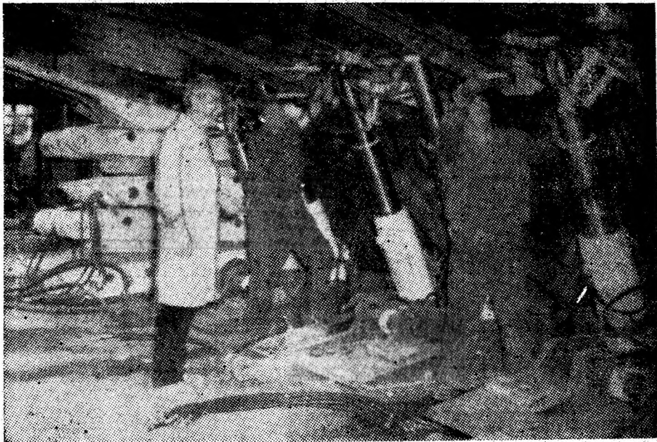
În atelierul de montaj susțineri mecanice, echipa condusă de Ioan Simu și Ioan Gagyi, lucrează la verificarea secțiilor SMAPH-2 înainte de a fi livrate minerilor de la Livezeni. Foto: Alexandru TĂTAR
