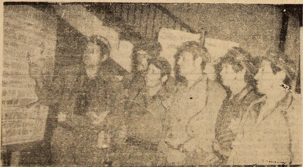
Una dintre principalele activități din subteran este aprovizionarea abatajelor cu materiale. În imagine, maestrul Hic Ștefan prelucrînd brigăzii de transport-aprovizionare, de la mina Uricani, condusă de Ioan Costea, necesitatea asigurării ritmice a tronturilor de lucru cu materialele necesare.
