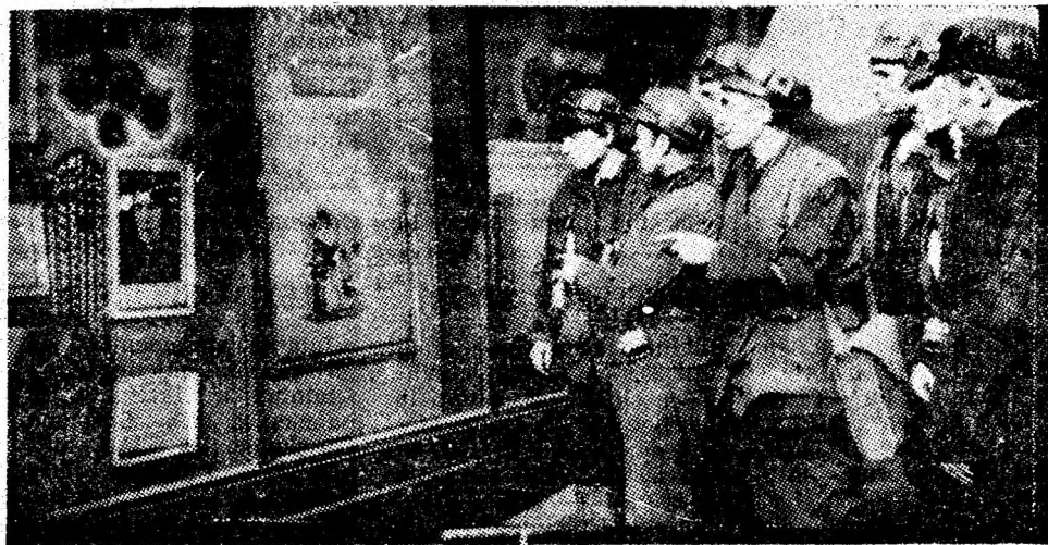
La gazetele de perete minerii urmăresc, ca într-o oglindă, aspectele muncii din subteran, rod al eforturilor depuse de colectivul minei Lupeni pentru extragerea cărbunelui cocsificabil.
