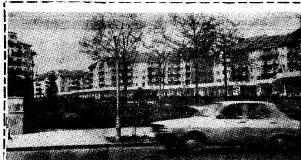
Aspect care vorbește despre amplitudinea procesului de modernizare social-edilitară din cartierul Petrosani-Nord.
