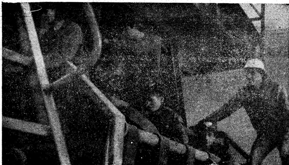
Echipa condusă de Traian Căpeț în timpul consolidării paletelor unui utilaj la noua preparație a cărbunelui Livezeni. Foto: I. LICIU
