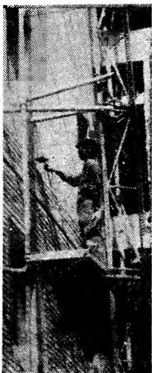
Construcții de locuințe — un reper cotidian în peisajul social al municipiului nostru.
