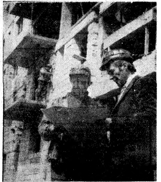
Activitate intensă și pe șantierele noilor blocuri de locuințe din Vulcan.
