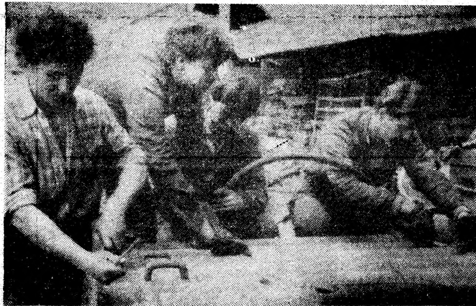
În plină activitate, la recondiționarea ștălpilor SVJ, echipa condusă de Iosif Keller.
