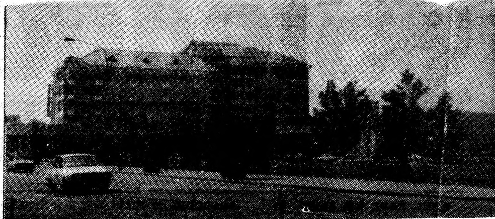
Realizările semnificative, din ultimul an, de pe bulevardul reședinței municipiului au drept cap de afiș Hotelul Petroșani, cuprins acum de briul zonei lor verzi, dînd locului o notă în plus de eleganță și confort urban.
