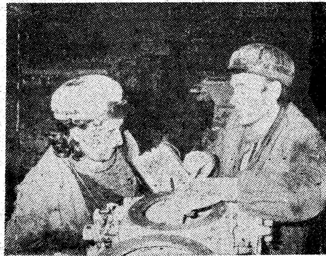
Vasile Albeanu și Dumitru Toma, doi apreciați electricieni la I.M. Petrila.
