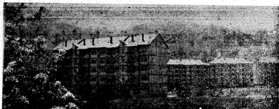
In Uricani, se conturează noi siluete ale blocurilor de locuințe, înaltate în cartierul Bucura. Foto: O. GEORGESCU
