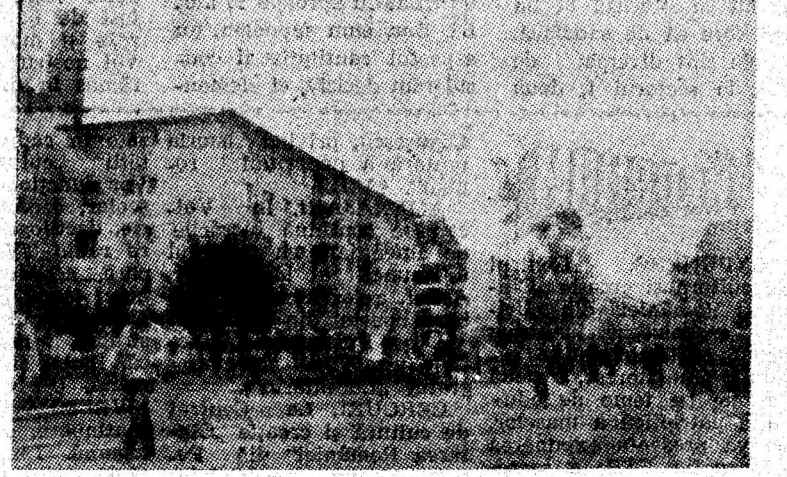
În poziția inițială, între blocul 57 și cel din spatele său exista o distanță de 11 m (foto stînga). La finalul operațiunii de translare cele două blocuri sînt alipite (foto dreapta). Foto, O. GEORGESCU
