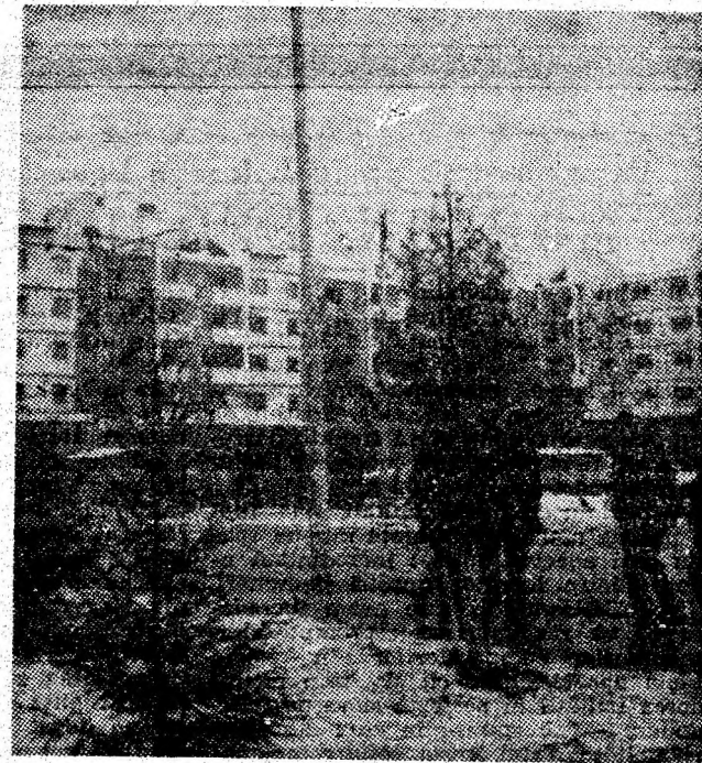
Uricani, în aceste zile de noiembrie, își etalează zestrea edilitară bogată în edificii moderne construite pentru mineri.
