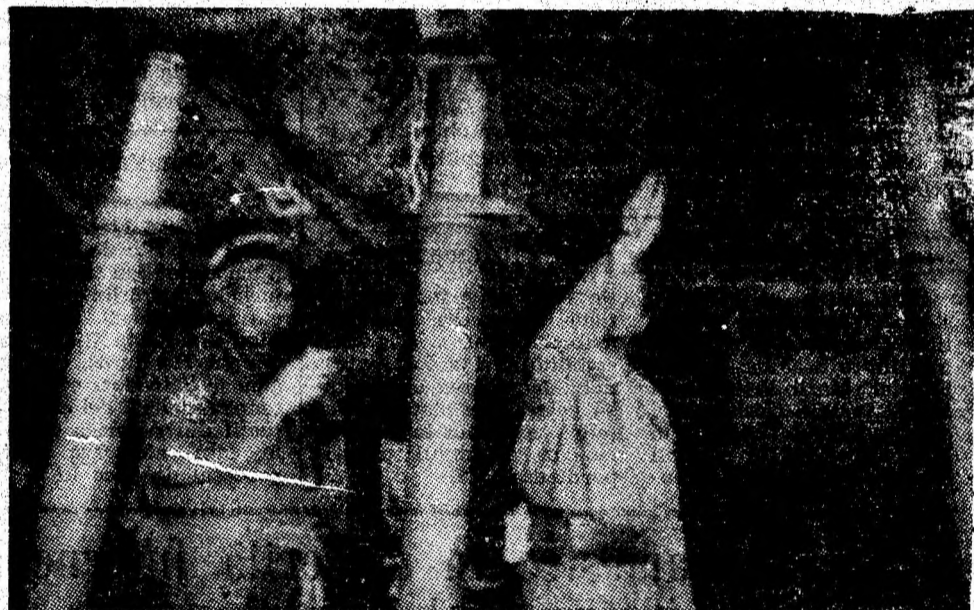
În abatajul condus de Ștefan Alba din sectorul IV al IM Petrița, tehnologia de lucru cu tavan de rezistență, stâlpi metalici de susținere și grinzi îngropate în vatră, permite realizarea unor importante producții suplimentare.
