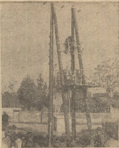
Controlul siguranțelor la transformator.
