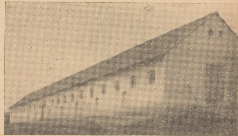
ÎN CLIȘEU: Maternitatea pentru scoafe de prașilă de la G.A.C. din Berghin, construită de curînd.
