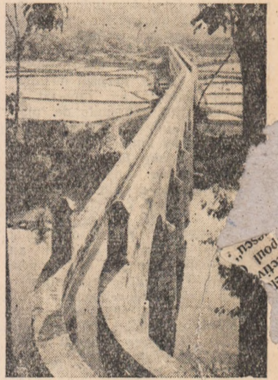
Nodul hidraulic de la Lienkian (sud-estul Chinei) asigură irigația a 1.400 ha de teren agricol. Barajul din fotografie are lungime de 98 m și o înălțime de 16 m.
