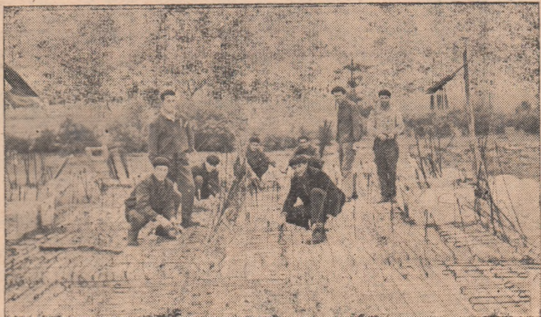
Echipa de fierari-betonisti condusa de tov. Păun N. de la șantierul 4 Alba Iulia este mereu în fruntea întrecerii socialiste.
