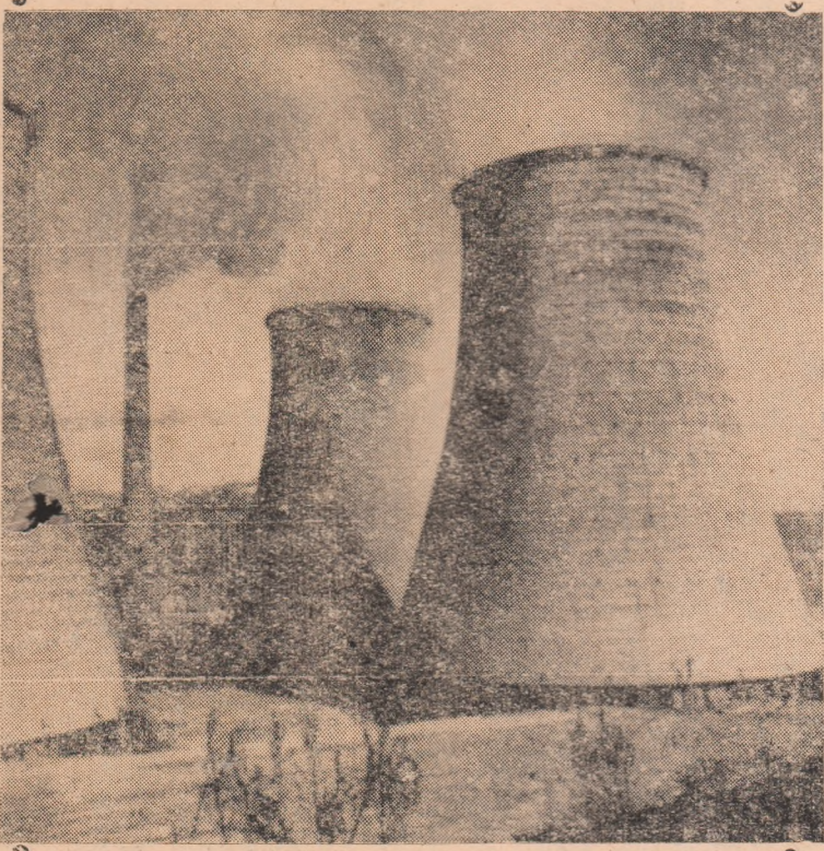
Termocentrala electrică de la Paroseni, unul din giganzii construiți și dați în folosință în anii regimului democrat popular, trimite pe calea firelor spre șantiere, fabrici și uzine milioane de kilovați energie.
