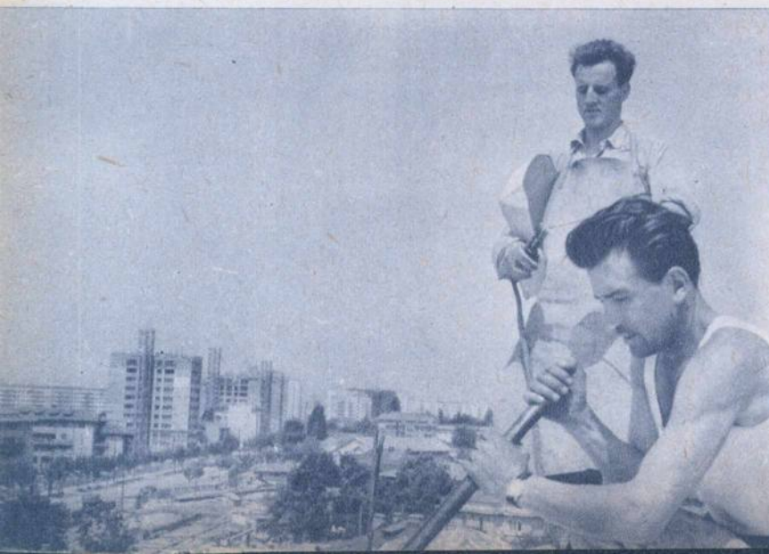
Și pe bulevardul 1 Mai din Capitală constructorii folosesc intens prefabricatele
