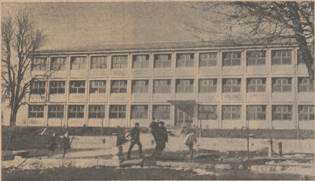
Clădirea nouă a Liceului din Baraolt, jud. Covasna
