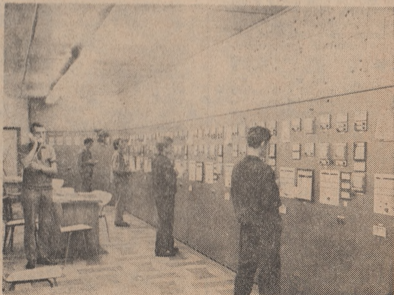
În camera de comandă automată
