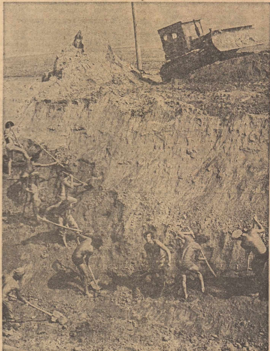
Intimpinăm 23 August prin muncă plină de dăruire. În imagine: studenți și elevi pe „Șantierul național al tineretului Giurgiu-Râsmirești“.
