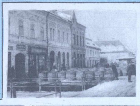
In centrul orașului Făgăraș stau depozitate de către Intr. Vin-alcooli butoaie care împiedică circulația.
