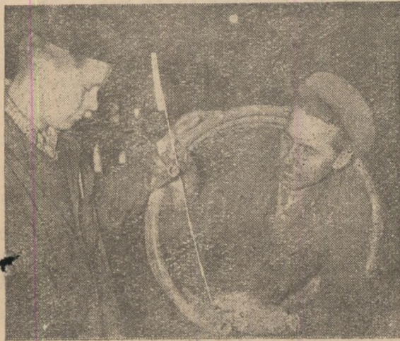
În prezența tînrului Gross Hanț, tehnicianul Furca Gheorghe din secția construcții metalice I.C.S.H. măsoară cotele unei serpentine pentru furnalele 5-6. Satisfacția e deplină: lucrarea a fost executată întocmai după proiect și cu precizie.
