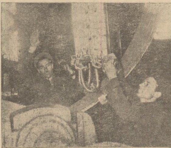
În clișeu: tehnicianul Furca Gheorghe și tânărul Ioan Virgil din secția construcțiilor metalice fiind în valț o virolă metalică pentru a fi îndoită conform șablonului.
