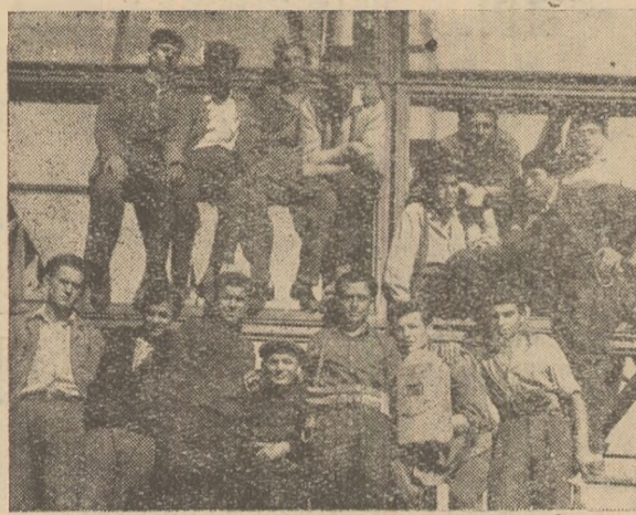
In clișeu; Brigada de confecții metalice de la hala atelierului mecanic a noilor linii de laminare.
