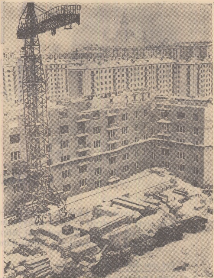
Locuințe în construcție în raionul de sud-vest al Moscovei.
