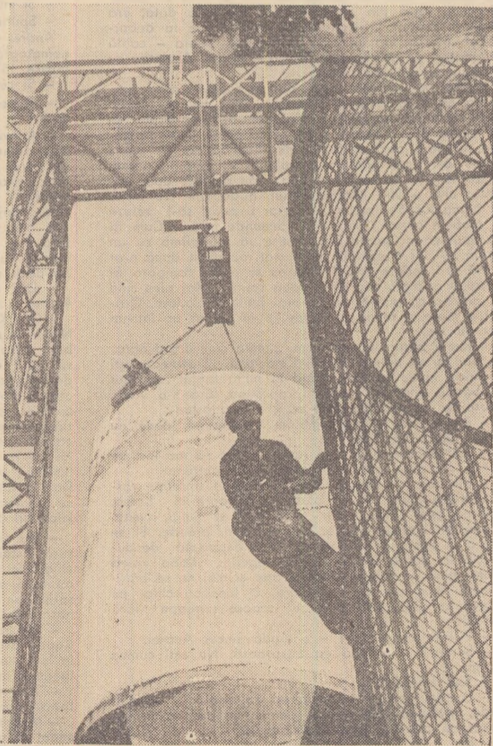
Între orașele Saratov și Engels, peste Volga, se construiește un mare pod pentru vehicule, cu o lungime totală de 2.803 metri, care va fi montat din elemente de beton armat și se va sprijini pe 39 de piloni
