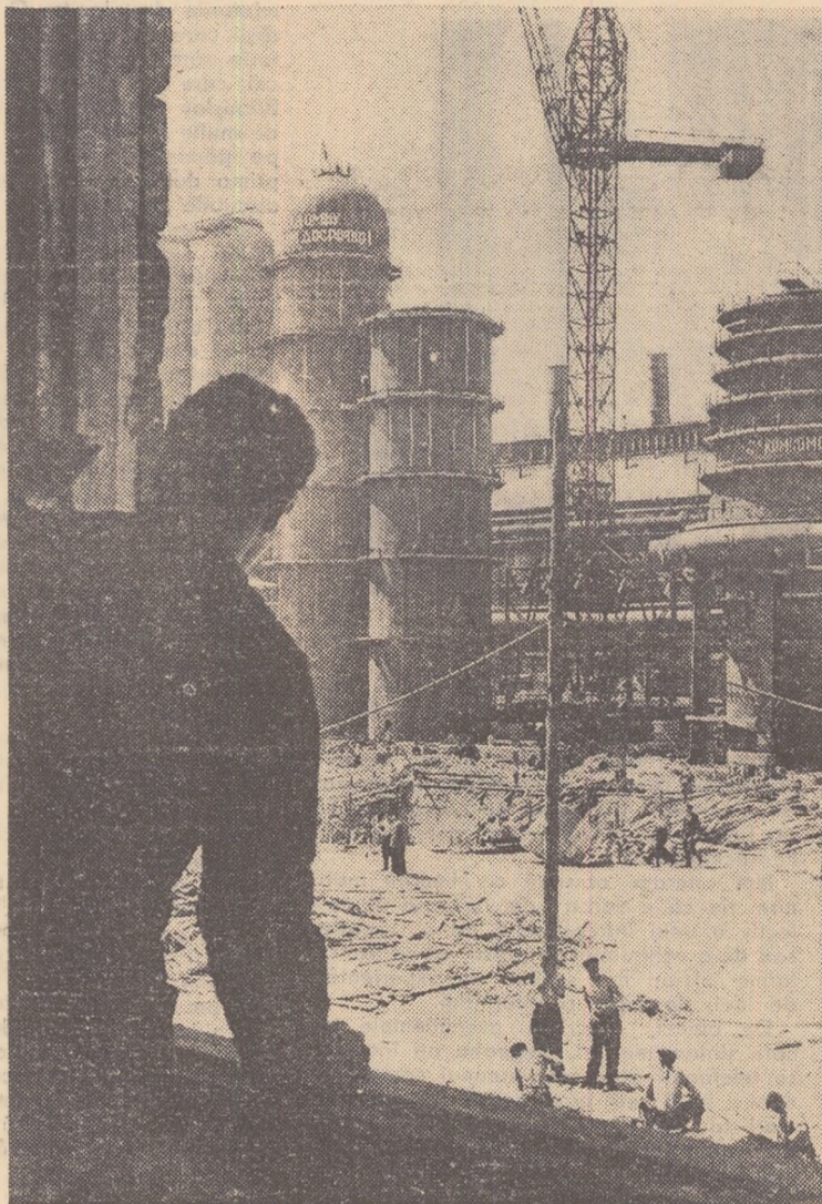
La Kuznetk se construiește un nou turnol...
