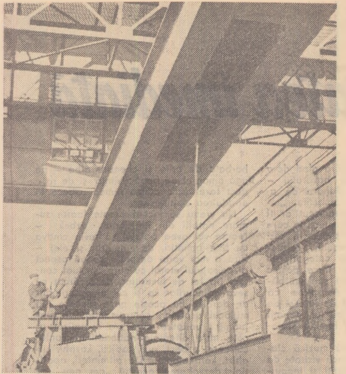
Tehnica secolului XX. Montajul unui pod metalic gigantic, în U.R.S.S.
