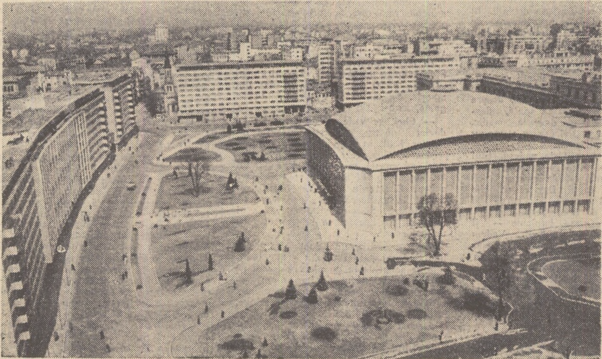
Anii marilor construcții. — În următorii 6 ani se vor construi din fondurile statului circa 300.000 apartamente.
