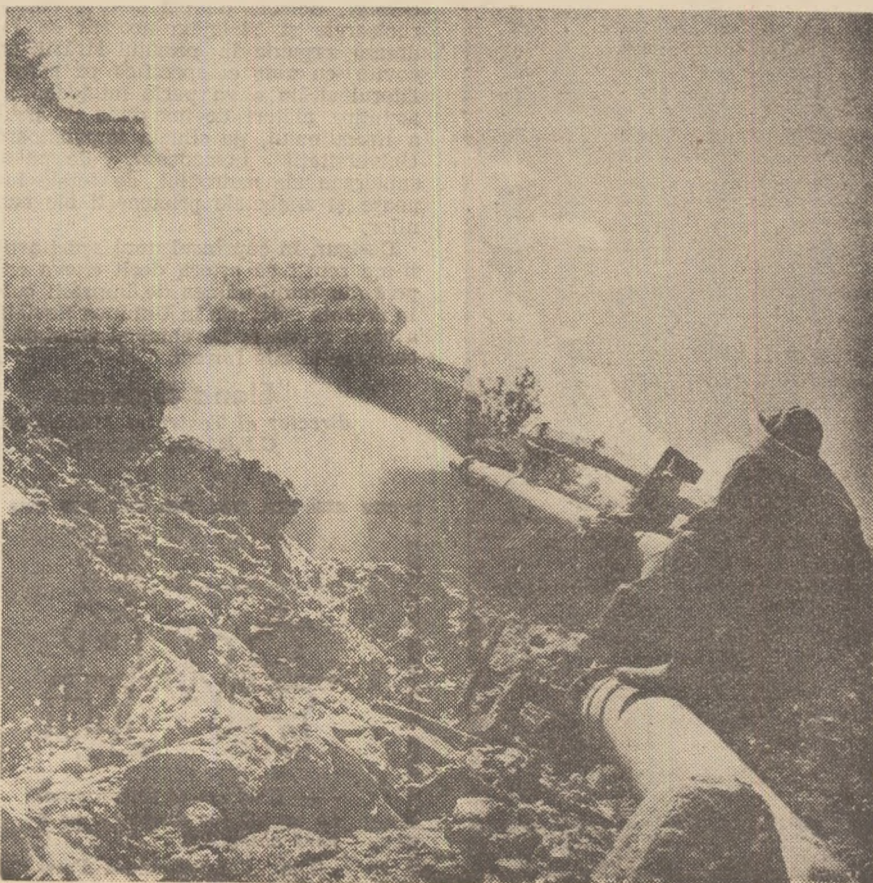
Exploatarea cărbunelui cu hidromonitoare (regiunea Kemerovo).
