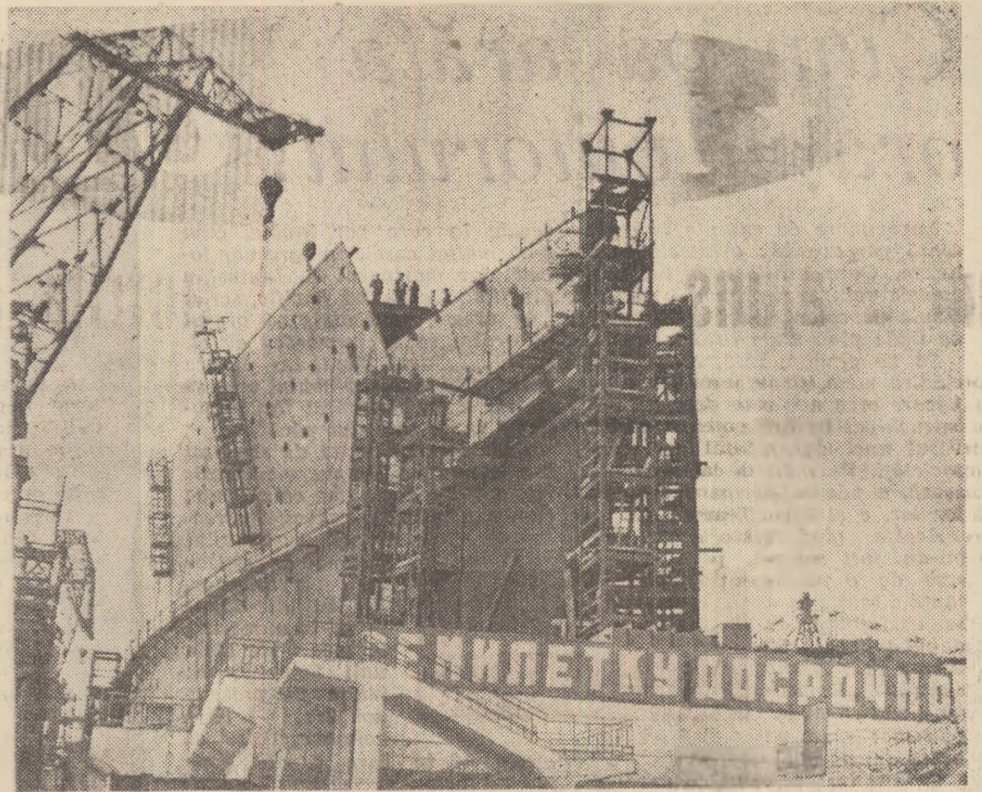
Pe șantier, o nouă navă-bază pentru flotilele de baleniere.
