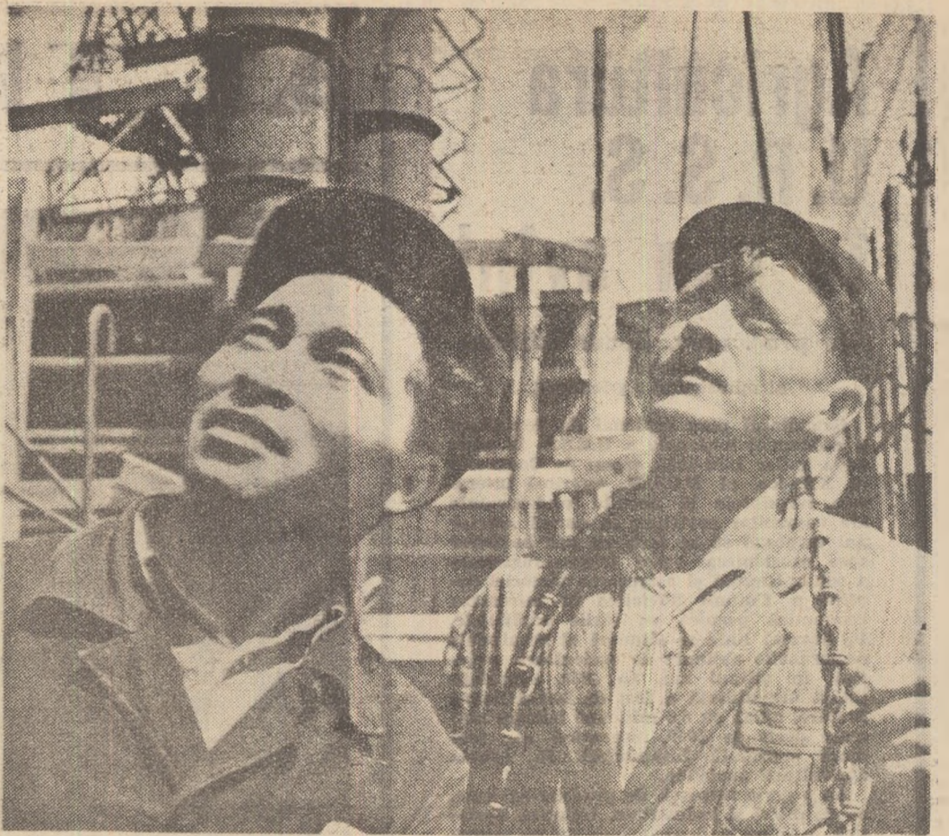
Pe șantierul hidrocentralei Buhtarmin din Kazahstan
