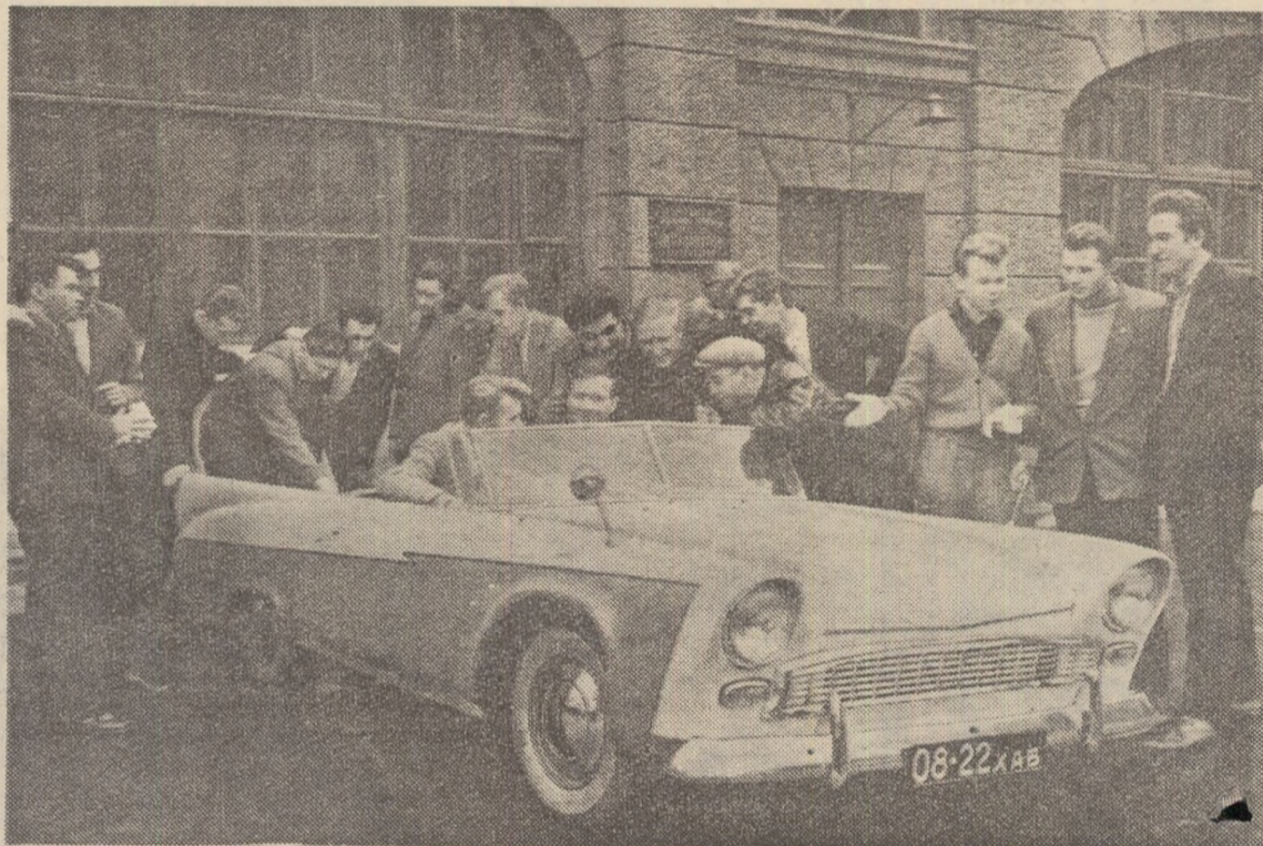
Membrii biroului studențesc de proiectare și construcții al Institutului de drumuri din Harkov au realizat un automobil de mic litraj de tip sportiv-turistic, pe care l-au botezat „HADI-2”. Automobilul cîntărește 450 de kilograme și dezvoltă o viteză de peste 100 de kilometri pe oră. În fotografie: grupul de studenți care a creat automobilul cercetîndu-l după rodaj.
