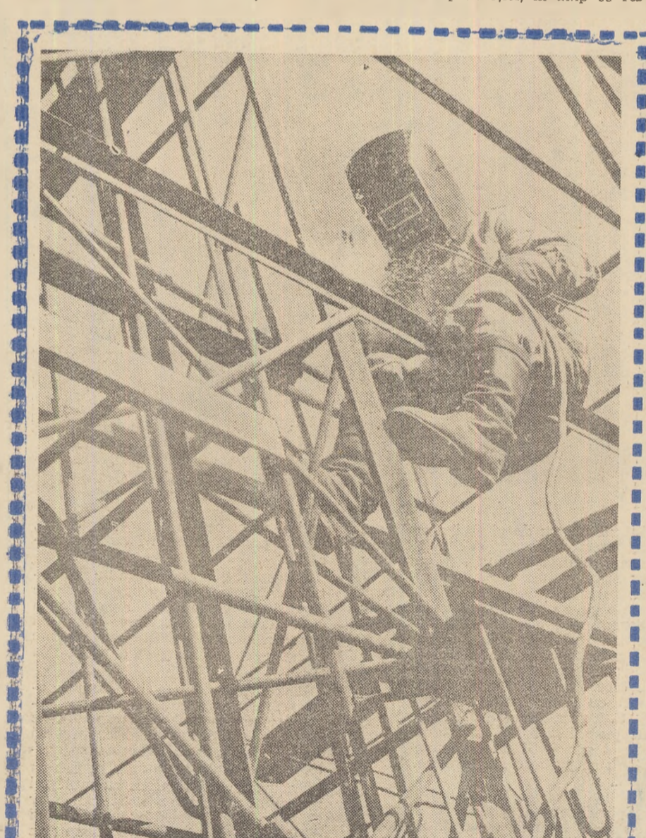
Pe șantierul centralei termoelectrice din Erevan
