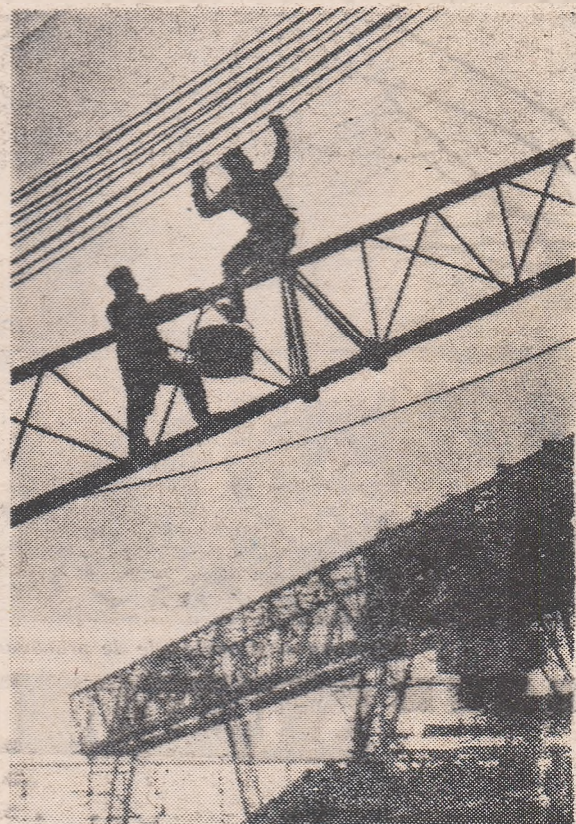
Montarea unei macarale-turn de 40 de tone pe șantierul Combinatului metalurgic Orsko-Hailovsk (regiunea Orenburg).
