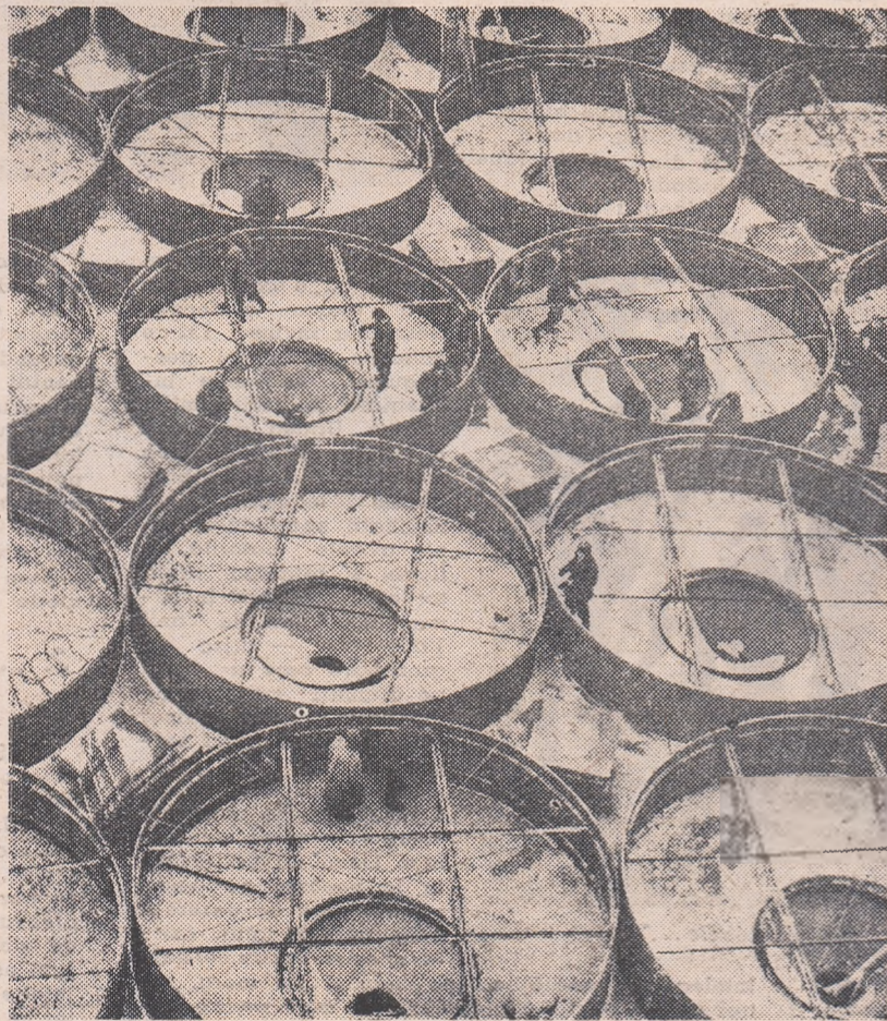
În finutul Telinnii se construiește un elevator cu o capacitate de 100.000 tone cereale.
