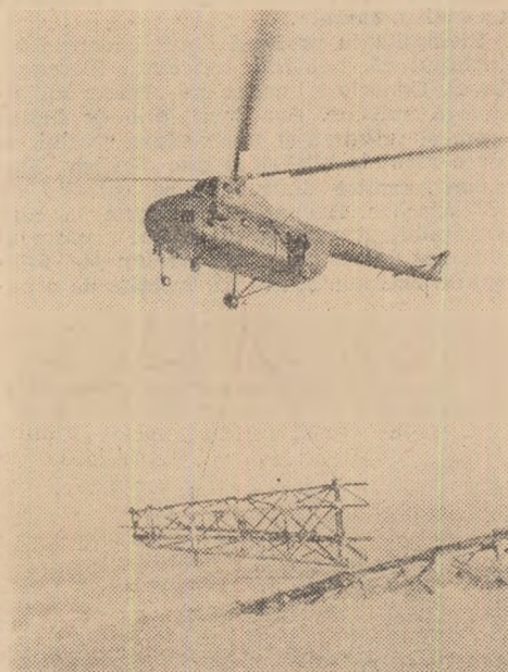
În regiunile greu accesibile, utilajul petrolier e transportat pe calea aerului
