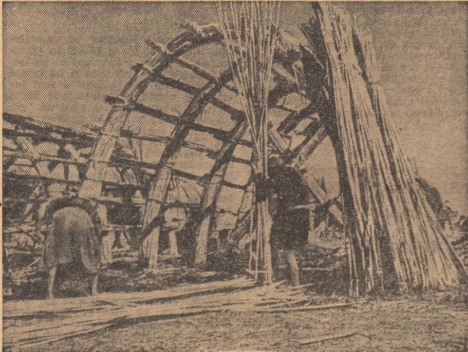
Doă ore de muncă cu spor și casa împletită din stuf își poate primi locatarii
