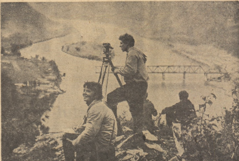
În curînd, aici se va deschide un mare șantier
