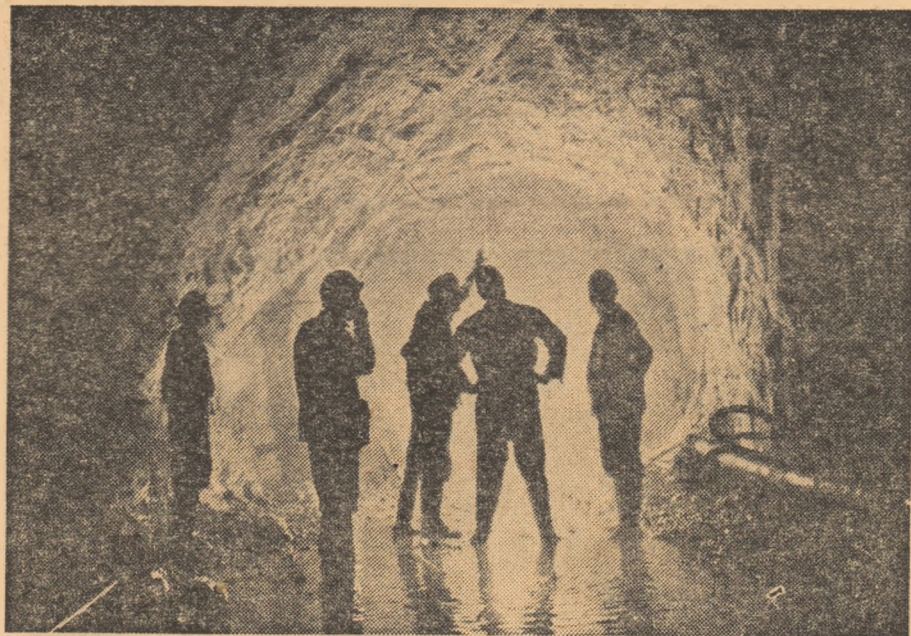
Lacul Sevan din Armenia, situat la o altitudine de aproape 2000 de metri, pierde în fiecare an mari cantități de apă. Spre a-i preveni secarea, în momentul de față se sapă un tunel de 48 kilometri prin care riul de munte Arpa, care curge la sud de Sevan, va vărsa anual în lac 300 milioane metri cubi de apă
