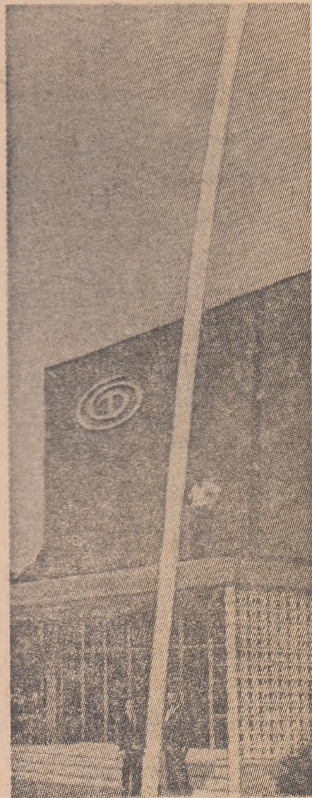
În forma-i inițială, antena din fotografie a fost un mic pachet cu o structură gonflabilă. În numai cîteva minute ea a devenit un tub de 30 de metri înălțime, rezistent la presiunea curenților de aer chiar la o viteză de 50 de metri pe secundă. Unul din cele trei straturi care alcătuiesc tubul este din hirtie pe suport sintetic
